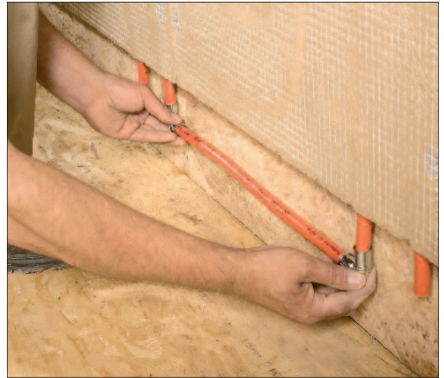
Abb. links: Klimatelemente werden in die in die Platte eingelassenen Halteteller verschraubt. – Abb. rechts: Nach der Montage an der Wand werden die Platten durch Rohre miteinander verbunden. (Fotos: WEM/meierei innenarchitekten, münchen)
