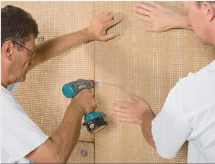
Abb. links: Klimatelemente werden in die in die Platte eingelassenen Halteteller verschraubt. – Abb. rechts: Nach der Montage an der Wand werden die Platten durch Rohre miteinander verbunden. (Fotos: WEM/meierei innenarchitekten, münchen)
