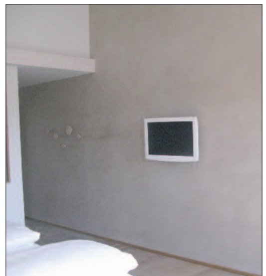
Links: Rohinstallation mit Klimatelementen und Lehmbauplatten in einem Hotel – Mitte: Die mit Lehmputz abgespachtelte Heizwand – Rechts: Die mit einem Lehmfeinputz fertiggestellte Wand – mit unsichtbarer Heizung
